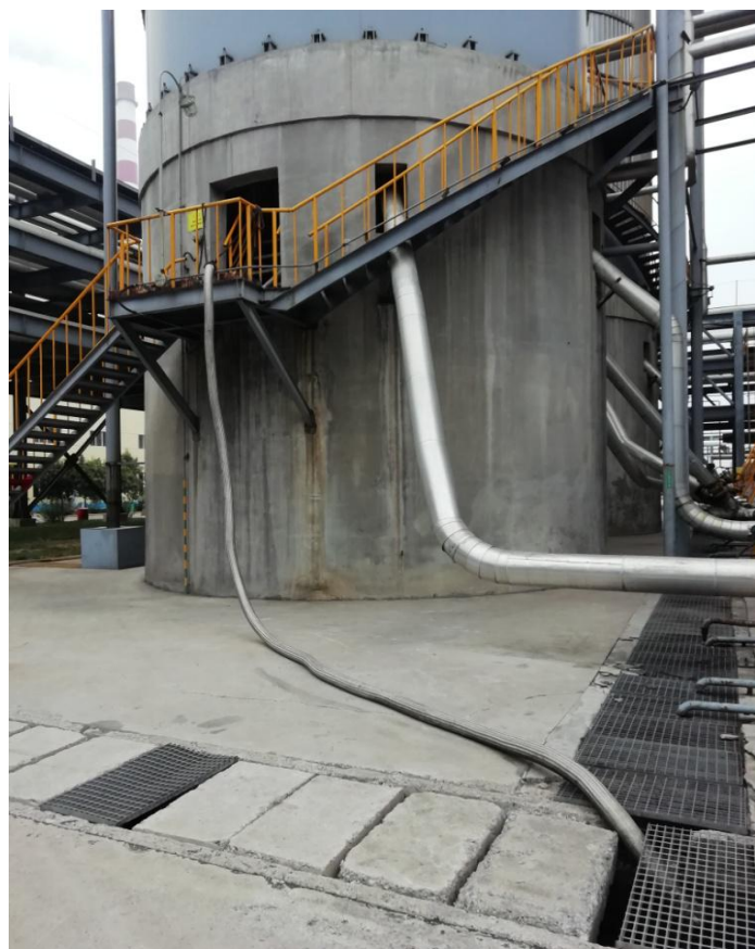
煤浆槽底部排放软管
