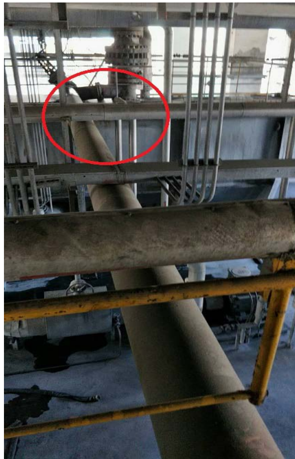
渣池连通管线
