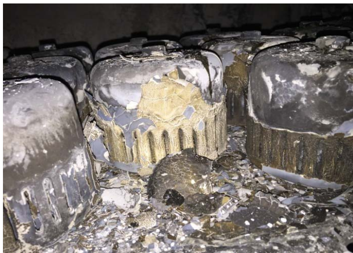
之前水洗塔塔盘结垢情况
