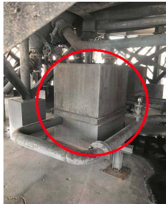
澄清槽底料泵增加过滤器
