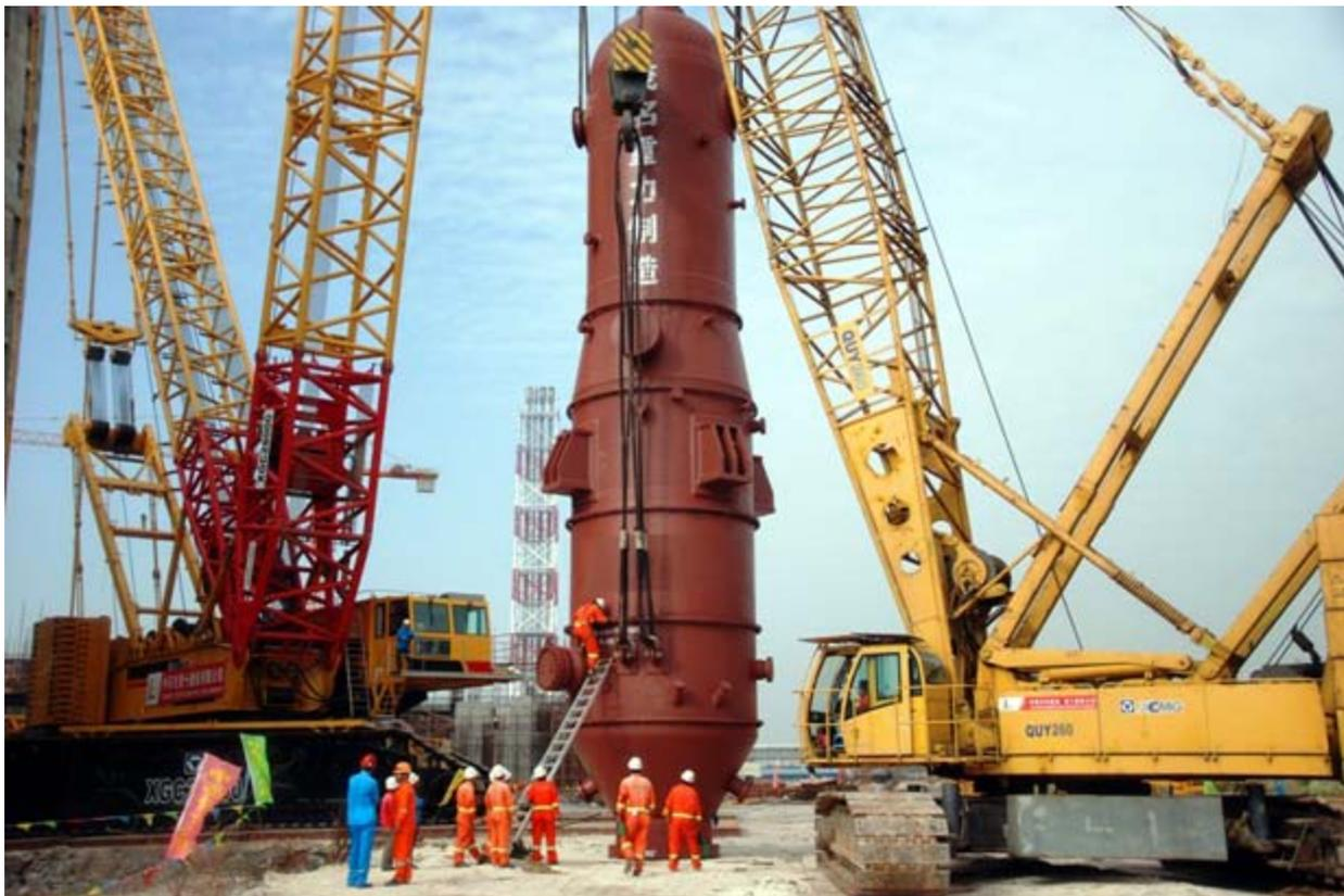
茂名重力石化机械制造有限公司制造的茂名煤制氢GE炉
