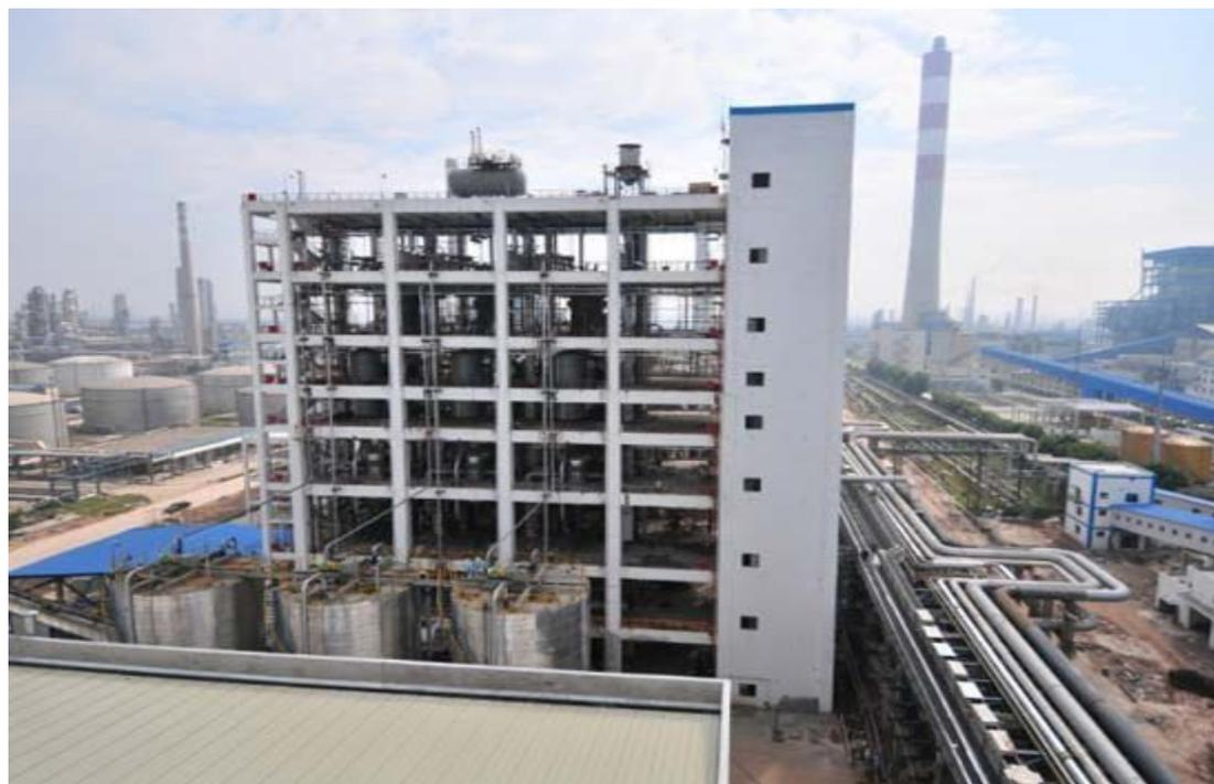
茂名石化公司油品质量升级改造工程的配套项目20万标立/小时煤制氢成功生产出合格氢气，标志着这套目前国内单产能力最大的煤制氢装置一次投产成功。水煤浆气化单元采用美国GE公司水煤浆气化技术。
