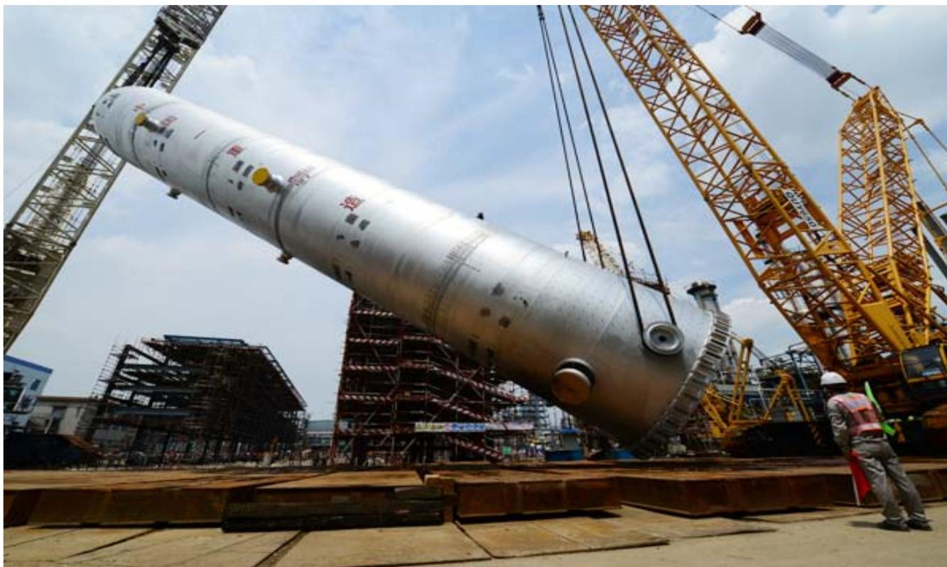
2016年6月21日下午，经过110分钟的吊装，自重达827吨、高36.7米的镇海炼化300万吨/年柴油加氢装置加氢精制反应器成功吊装
