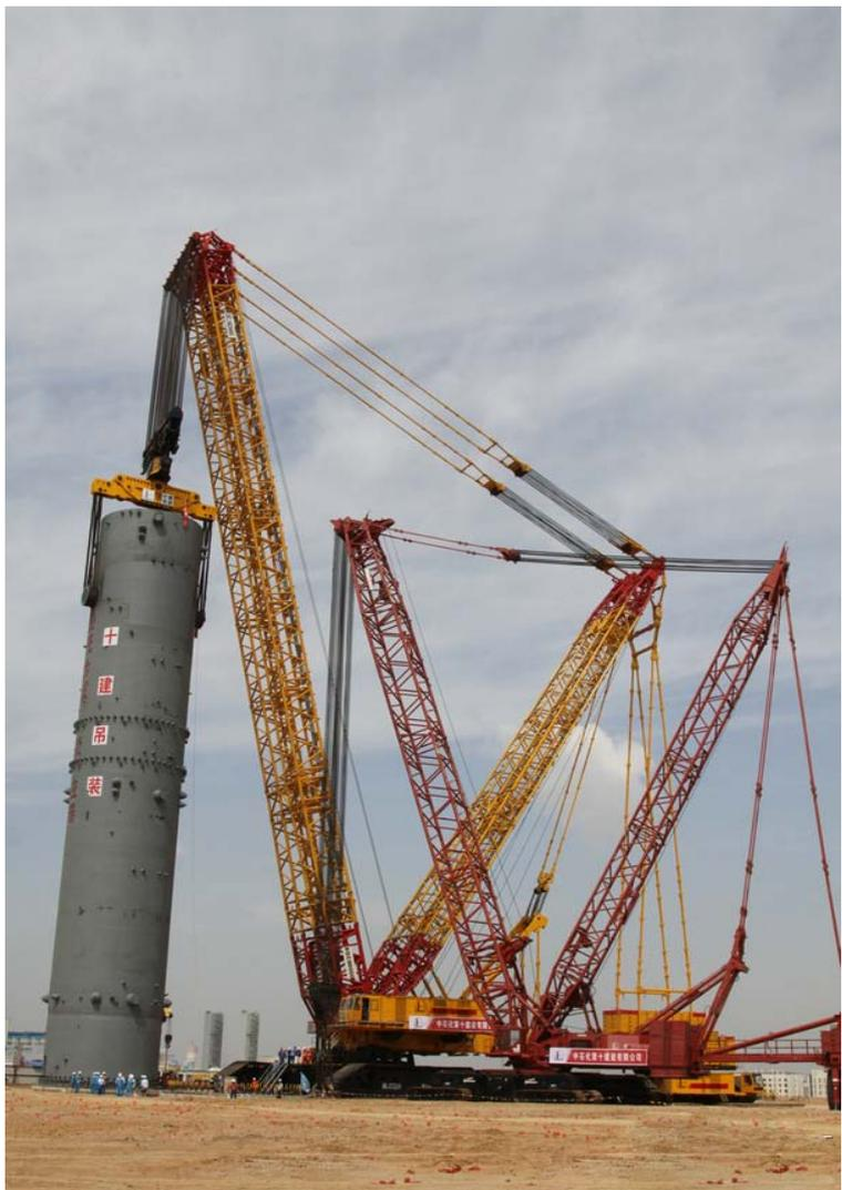
费托反应器直径9.6米，高60.971米，重2155吨
