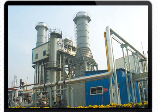
煤气化发电与甲醇联产技术 (IGCC多联产)
