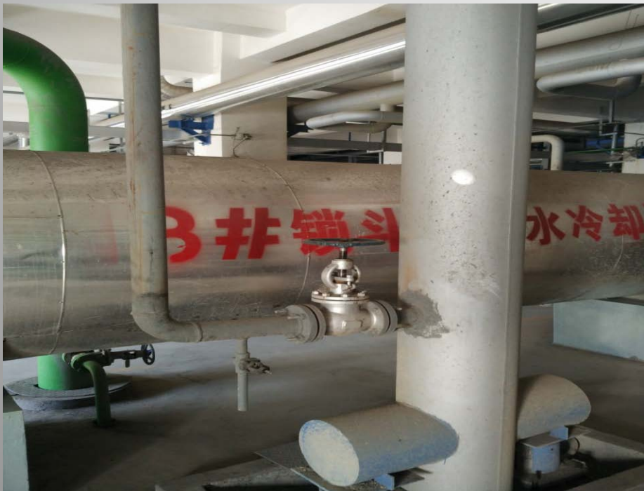
现场低压灰水并入冲洗水管网作为冲洗用水
