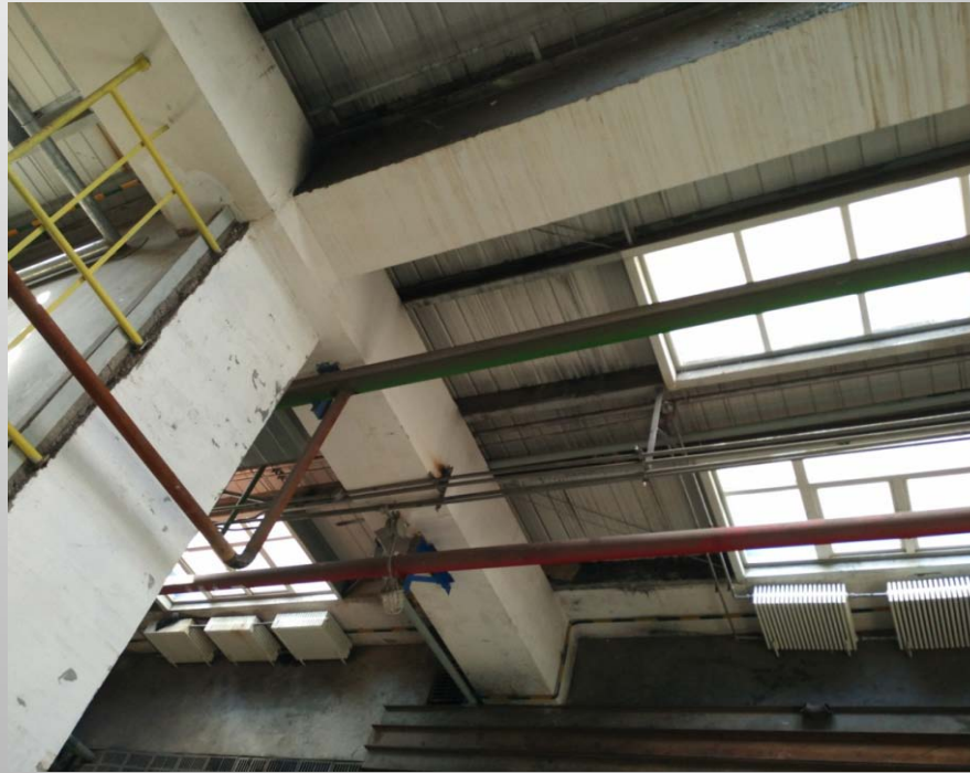
现场低压灰水并入冲洗水管网作为冲洗用水
