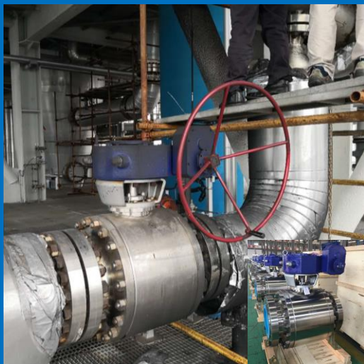
中海油惠炼煤制氢装置 合成气切断阀 (F316+INCONEL625) 2018年7月
