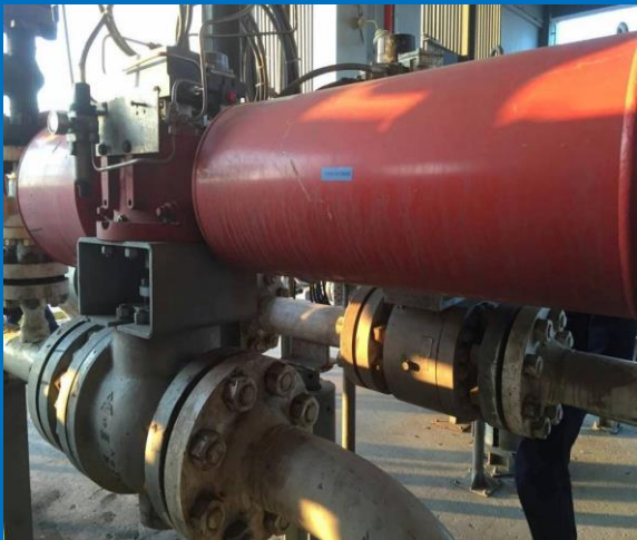
万华化学集团 煤浆循环管线回流调节阀 5.4MPa带压联投 2014年9月
