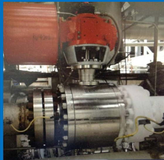
金新化工 分子筛C型球阀 代替ORBIT轨道球阀 2016年8月
