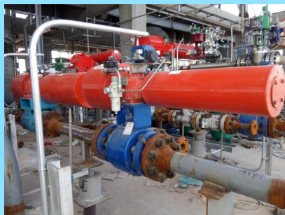
煤浆回流管线C&V调节球阀
