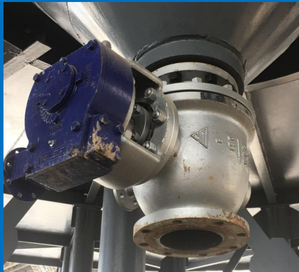
延长能化 煤浆槽罐底切断阀 (沉降槽) 取代柱塞阀 2018年9月
