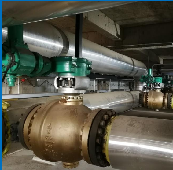
兖矿荣信 激冷水泵切断阀 2019年
