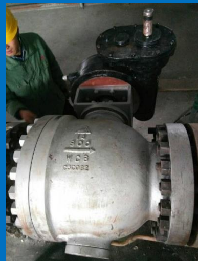
新疆心连心 激冷水泵切断阀 2014年9月
