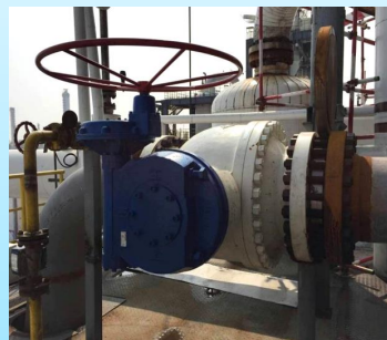
合成气切断阀
