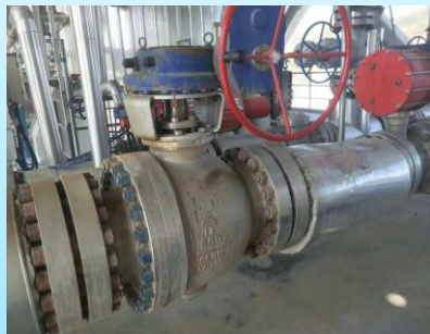
黑水、灰水及煤浆切断阀
