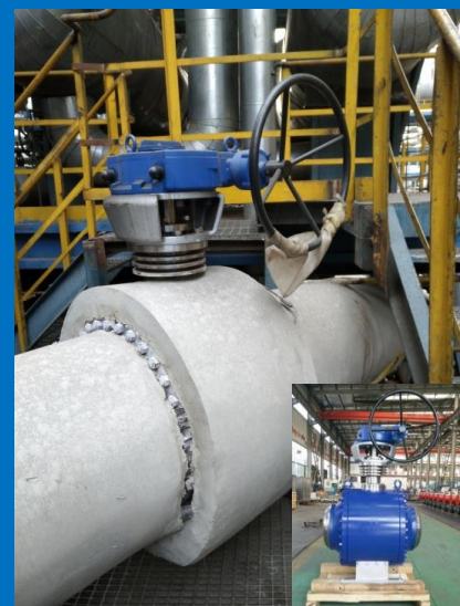
神华鄂尔多斯煤制油 高温油煤浆切断阀 取代 德国HARTMANN 球阀 2015年3月
