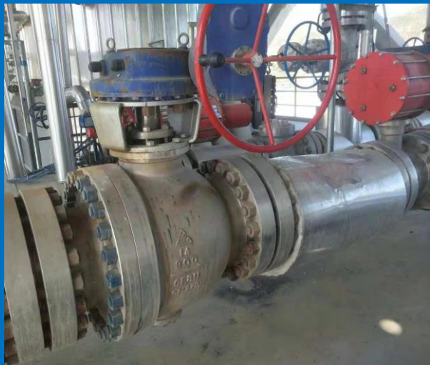
延长能化 高压黑灰水切断阀 2018年8月
