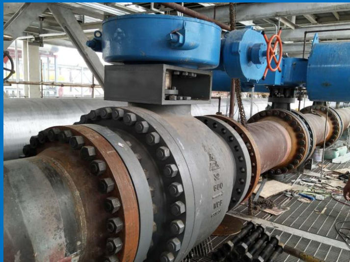
宁夏宝丰能源合成装置 合成界区总管手阀 2020年5月
