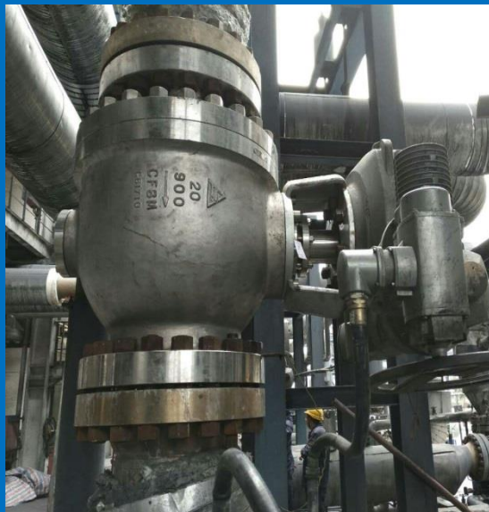
蒲城清洁能源 8.7MPa激冷水泵切断球阀 2015年10月
