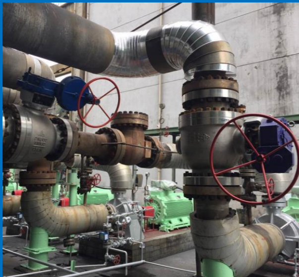
中石化南京分公司 8.7MPa激冷水泵切断阀 2016年12月
