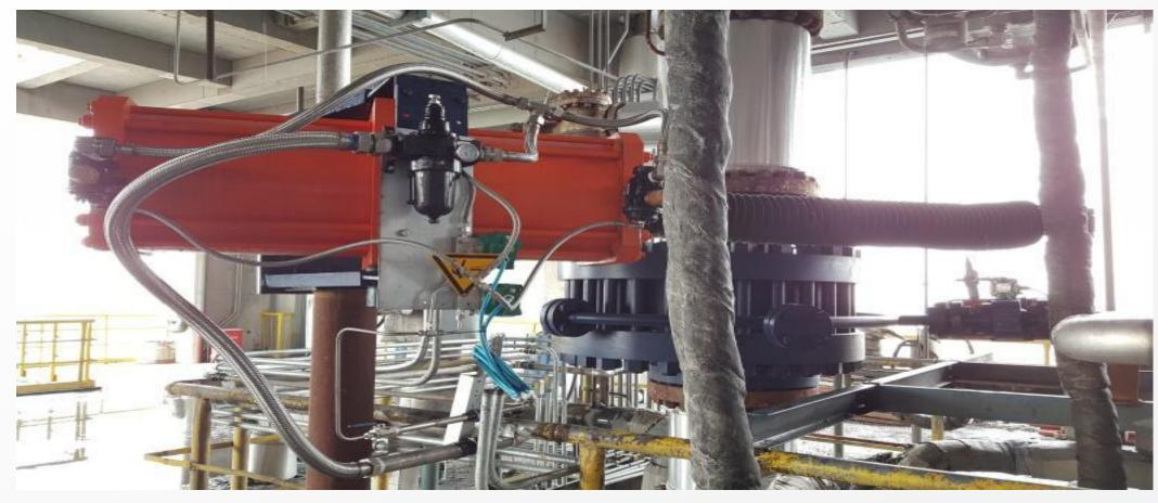
2016-02-09在中石化长城能源现场安装上线,位号KV-1103,运行至今,其间从未检修维护过,后续采购6台盘阀替换进口球阀。
