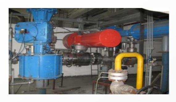
NPS 8 CLASS1500 全INCONEL材质的高压氧阀在新奥包头2013年9月9日正式投入运行,应用工位为XV-1201A,主要用于氧气管线放空切断,2014、2015、2017年新奥分别向我们购买相同或类似工况阀门7台。
