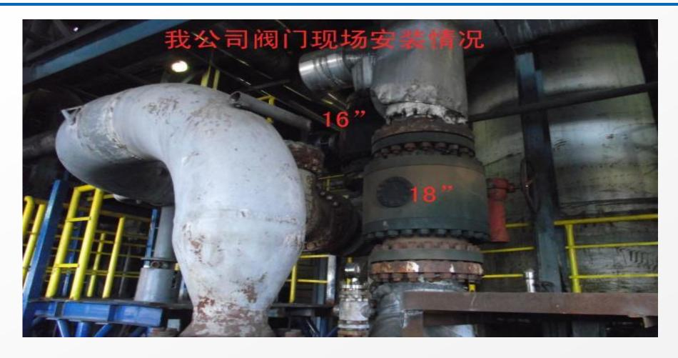
内蒙新能现场,16-900#,18-900#,激冷水泵进出口阀门,使用超过3年,效果良好,再未出现过卡涩和内泄漏
