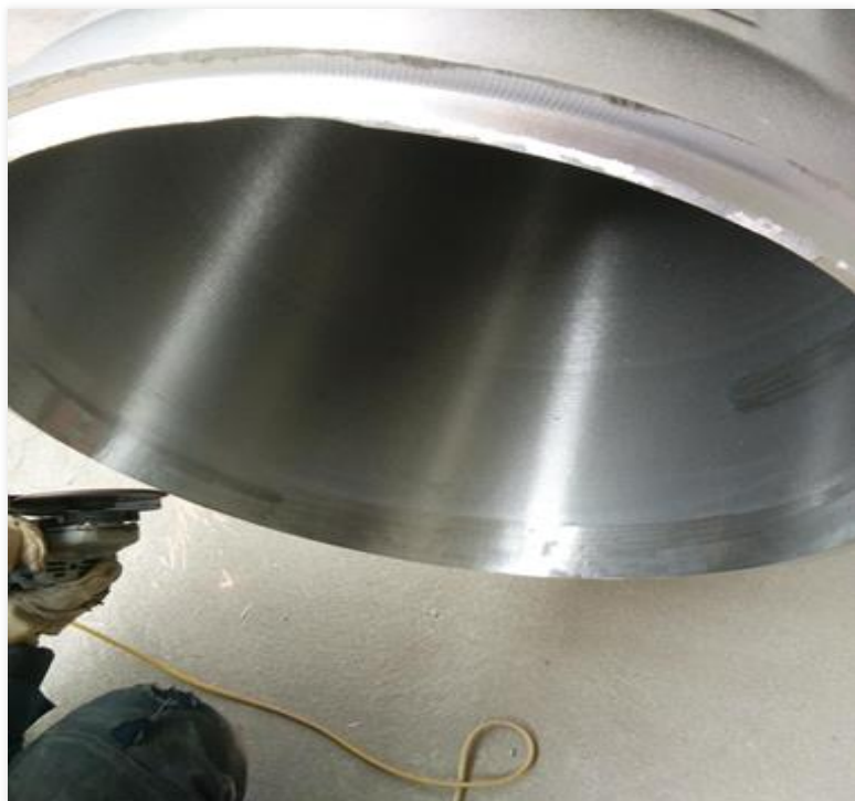
对口前清洁化+坡口
