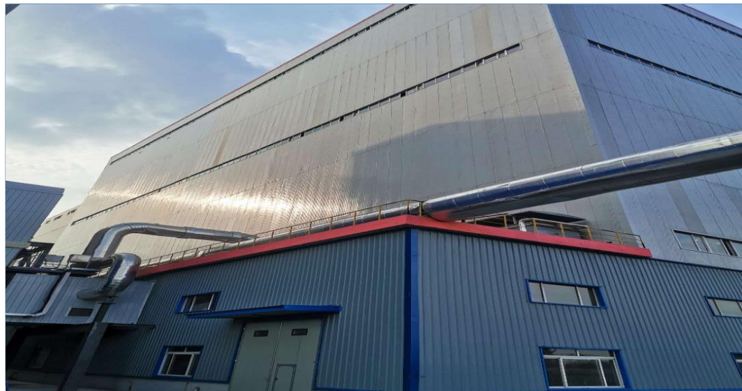
二期两台380t/h循环流化床锅炉
