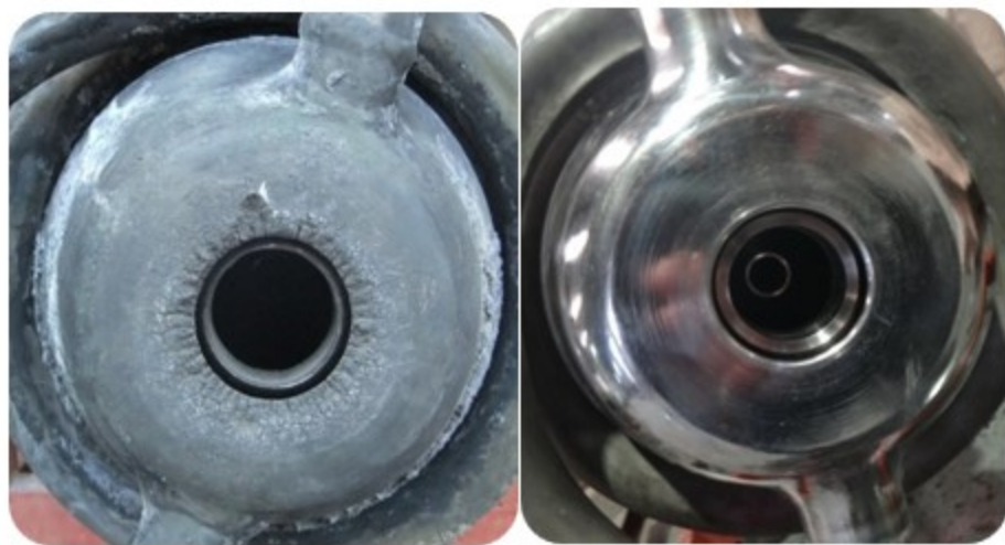
烧嘴维修前后对比
