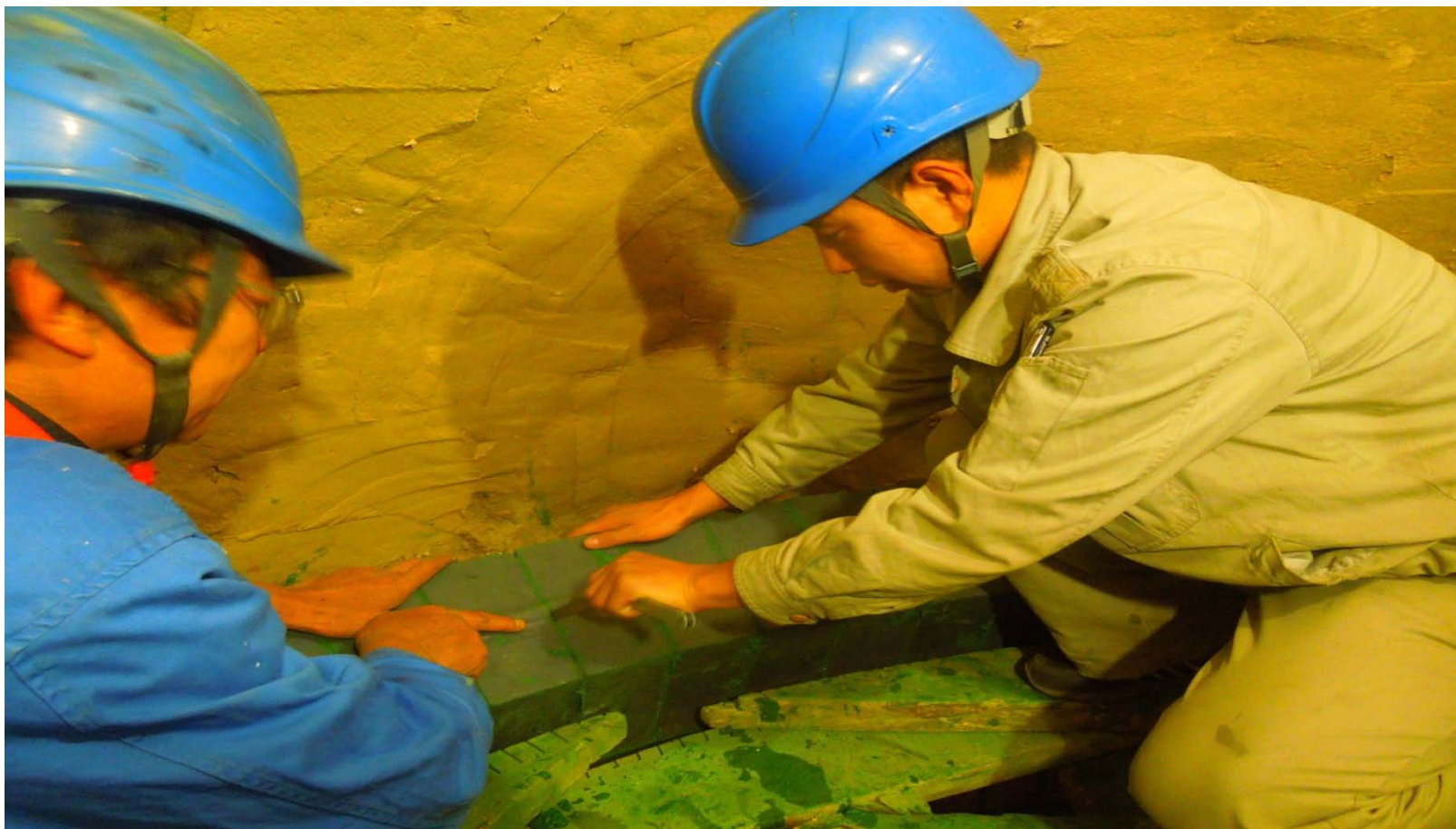
图为主管技术员对炉砖砌筑进行验收
