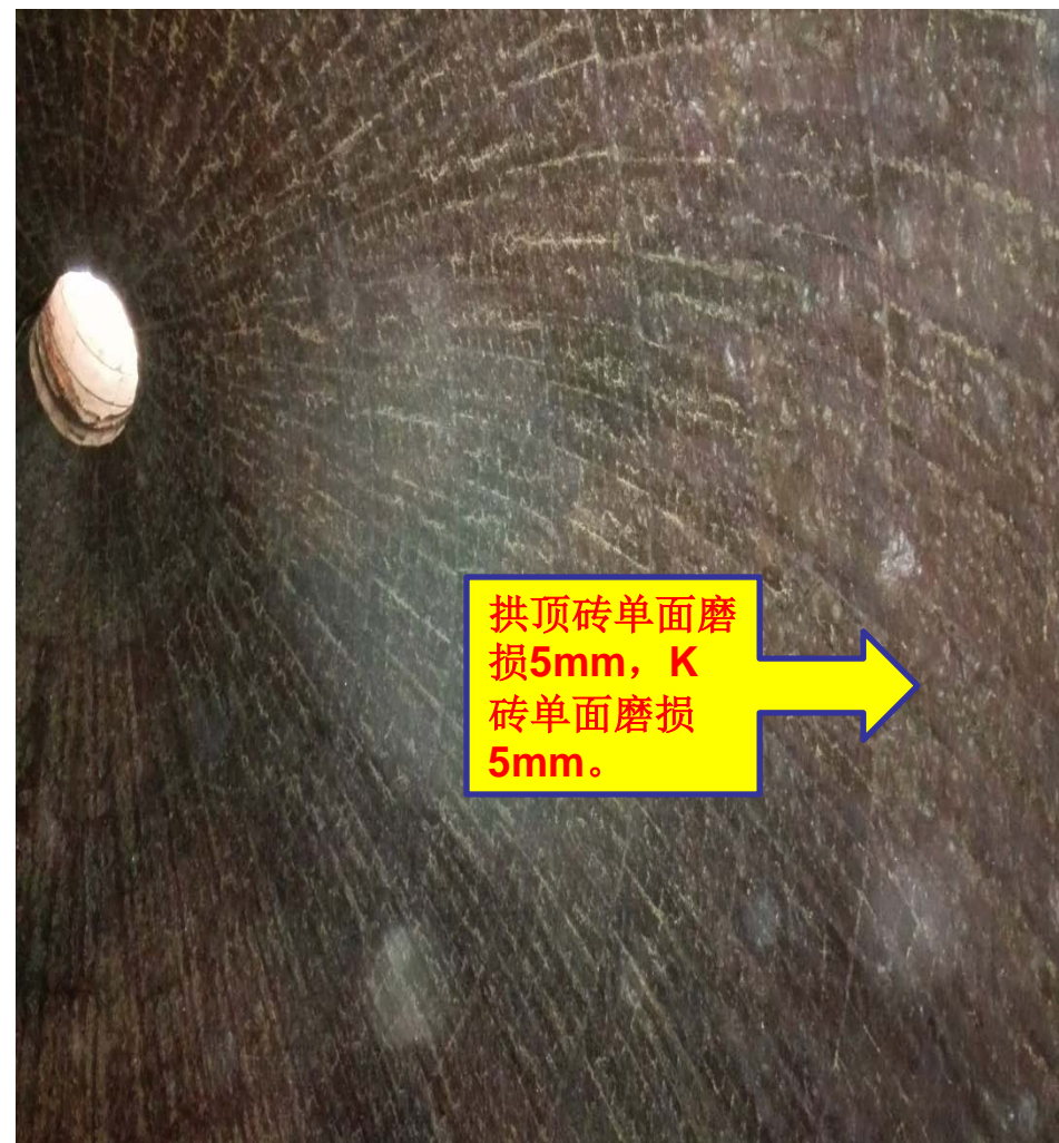
2015年2月C炉拱顶砖低温运行100天后效果良好
