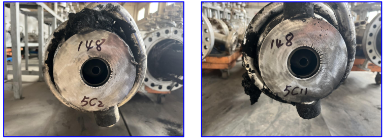
5#气化炉运行148天后的工艺烧嘴头部情况
