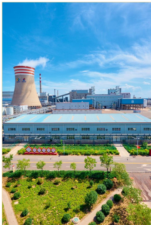
4000吨级水煤浆激 冷工业示范
