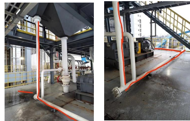
二级滚筒筛粗粒子管线比较细，DN100，有3个90度弯头
