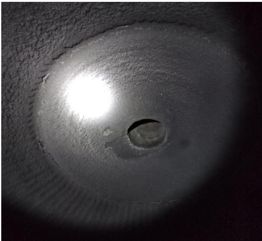
图2：水冷壁拱顶处挂渣情况
