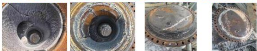
LV38003B2缓冲罐检修前后
