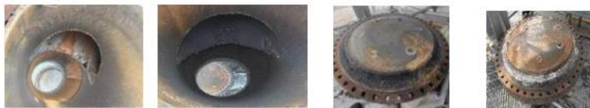
LV38003B1缓冲罐检修前后
