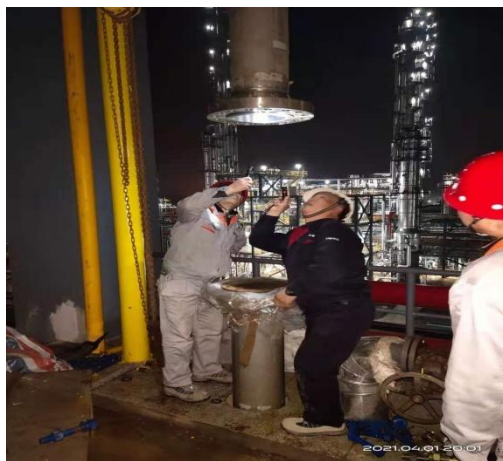
2020年9月-4月24日氧氮气管线预制安装至吹扫合格
