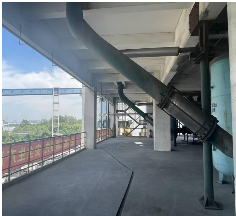
锁斗冲洗水管线弯头整改
