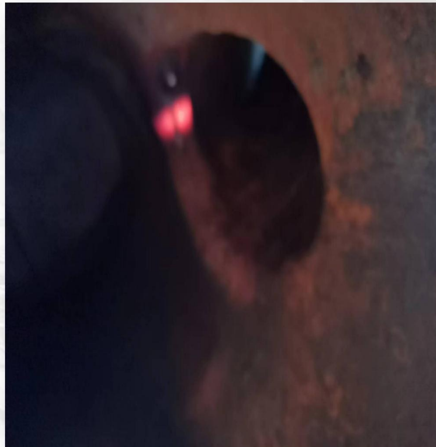
高压煤浆泵入口管分叉口，该部位容易忽略，测厚难度大，需拆检检查
