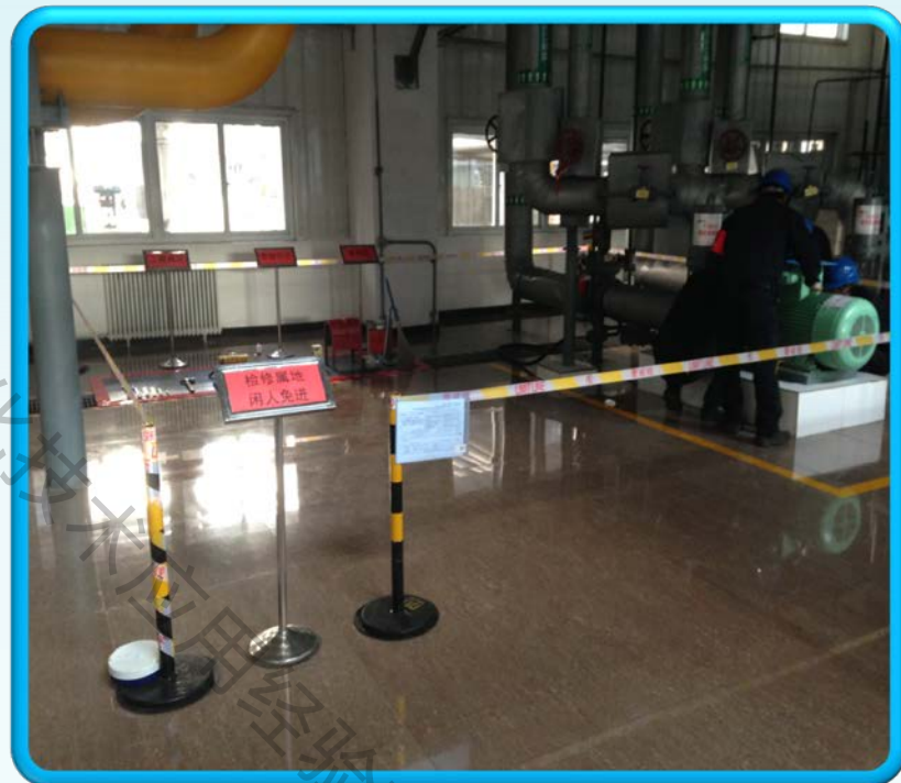
锅炉给水泵检修现场
