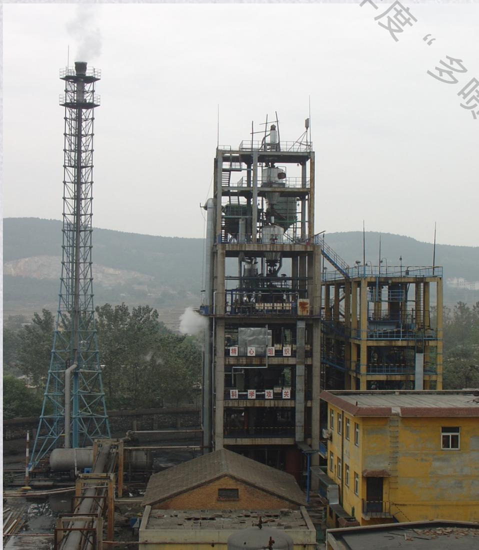
与华东理工大学、中国天辰化学工程公司共同承担了国家“十五”攻关项目“粉煤加压气化制合成气新技术研究与开发”，建成了具有自主知识产权的粉煤加压气化中试装置。
