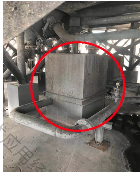
澄清槽底料泵增加过滤器
