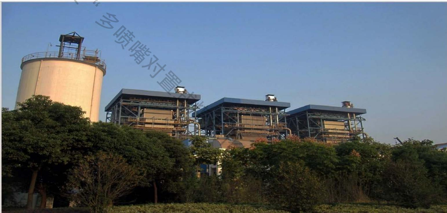
热电装置设置3×240t/h 循环流化床锅炉（两开一备）+25MW抽汽凝汽式汽轮发电机组+15MW背压式汽轮发电机组，向全厂供出高、中、低压蒸汽。
