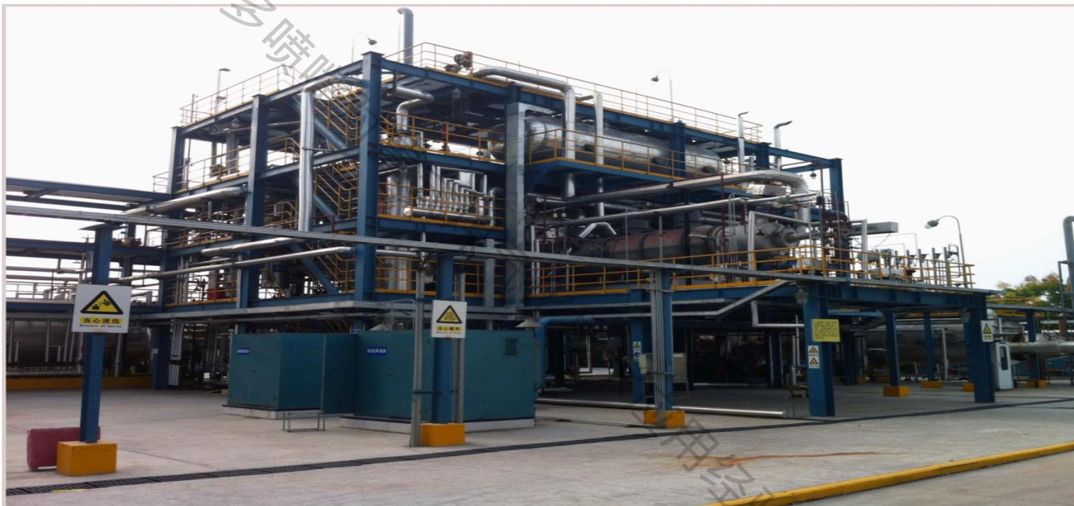
采用荷兰荷丰三级克劳斯硫回收工艺，回收酸性气中的硫，硫回收尾气经焚烧炉焚烧后送热电锅炉燃烧后去烟囱高空排放，以确保满足环保的要求。
