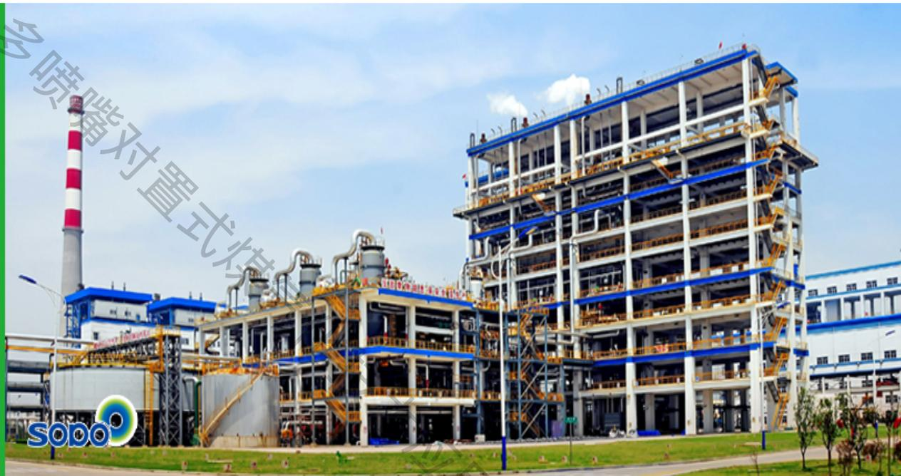
采用华东理工大学四喷嘴水煤浆气化炉，设计压力6.5 MPa，日处理煤量1500t，两开一备模式运行。
