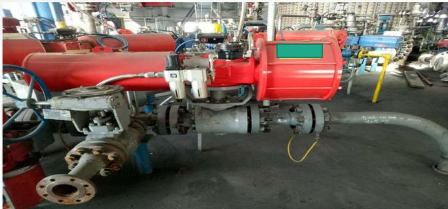
选型试验新阀门(V型金属密封耐磨球阀)
