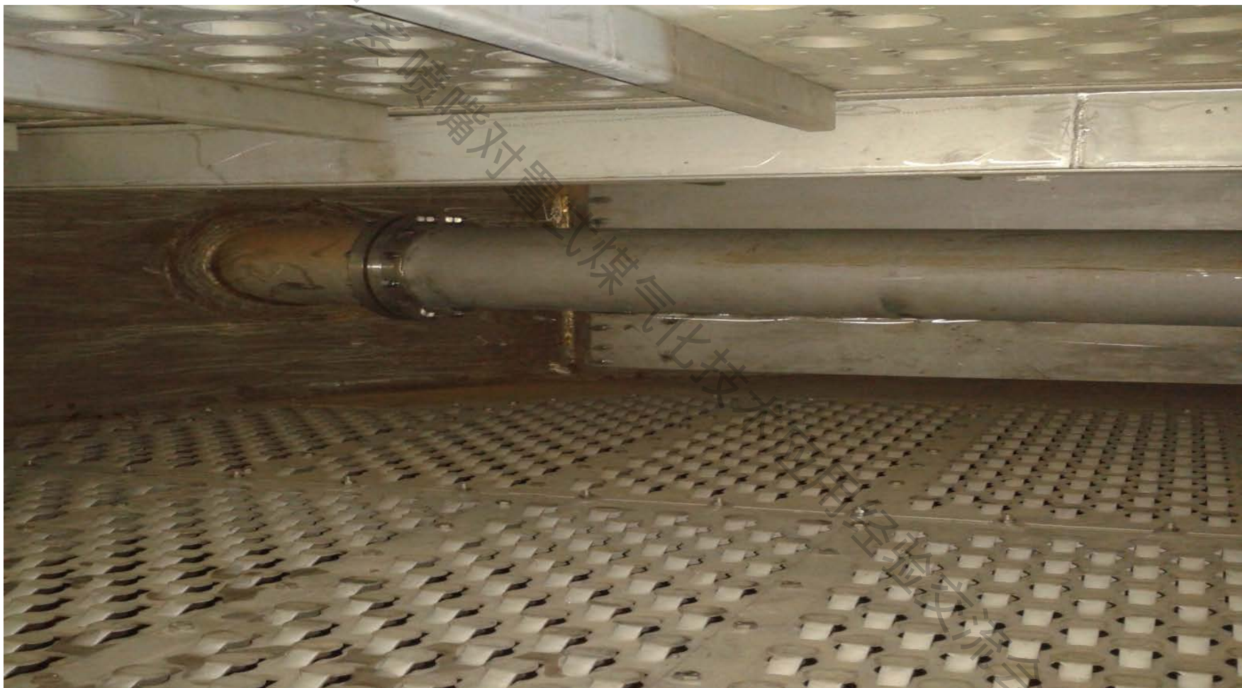
塔盘安装后的情况
