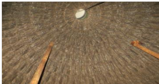
A炉运行14280h的拱顶砖
