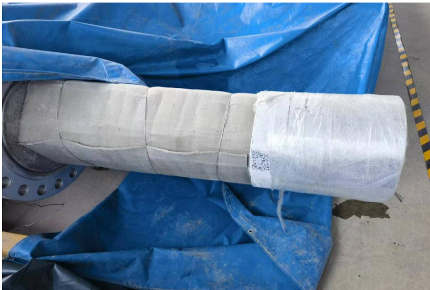
安装前烧嘴的防护
