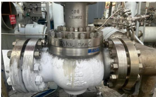
奥科供晋巨合成甲醇洗-分子筛工况 高低温交替耐磨半球切断阀-现场使用
