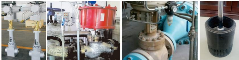
兖矿新疆煤化工有限公司 锅炉主给水调节阀
