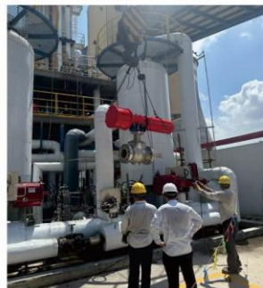
奥科供晋巨合成甲醇洗-分子筛液氮洗工况 高低温交替耐磨半球切断阀-现场安装照片
