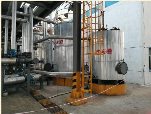
进水端增加滤液槽和滤液泵，稳定进水压力和流量，稳定工况。
