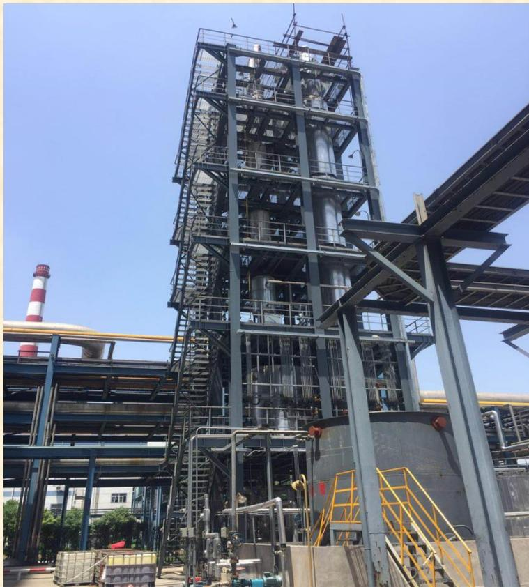
氨回收是利用汽提塔汽提凝液制备浓度 $\geq 20\%$ 的氨水的装置。氨回收装置可以避免氨氮在系统中的积聚，降低了系统的氨氮（目前气化外排灰水中氨氮控制在 $350\text{mg/L}$ 以下），氨回收处理后的废水氨氮降低至 $\leq 150\text{mg/l}$ ；
