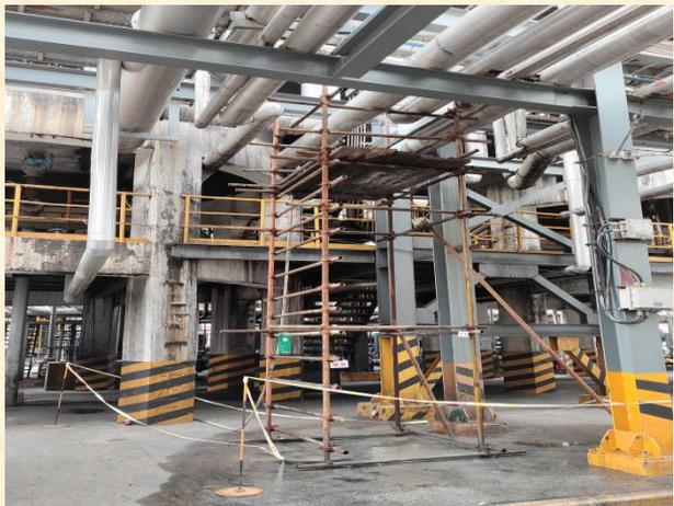
将腐蚀严重不锈钢设备、管道，更换为钛材，减少泄漏，提高运行可靠性。
