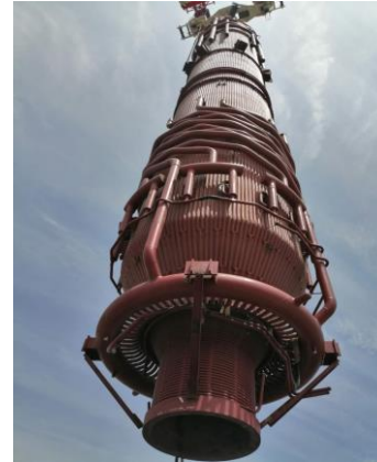
辐射废锅内件吊装
