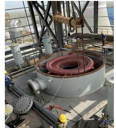
辐射废锅内件 安装就位
