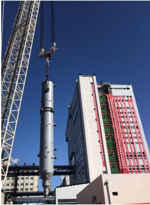
气化炉壳体及吊装
