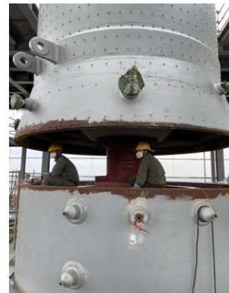
气化燃烧室段与辐射废 锅段合口
